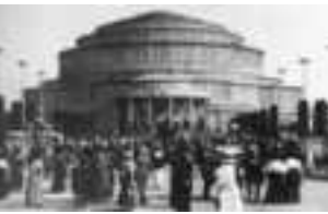
Abb. 6: Jahrhunderthalle Breslau, Foto, 1913
